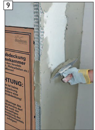
9 Haftbrückenauftrag vornehmen - max. Auftragsdicke 5 mm.
