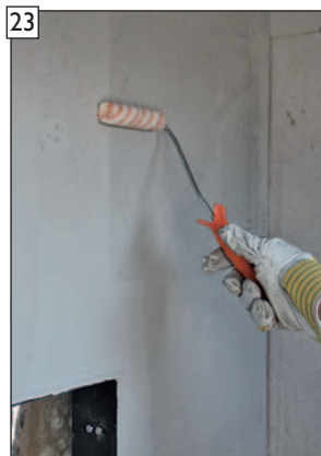
23 Grundierung StoPrim Plex aufbringen.
