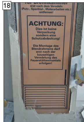
18 Oberputz an den Öffnungen auftragen und ...
