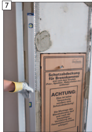
Eckprofile lotrecht ausrichten.
