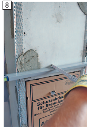
Erforderliche Putzdicke überprüfen und Eck- sowie Anschlussprofile entsprechend einstellen.
