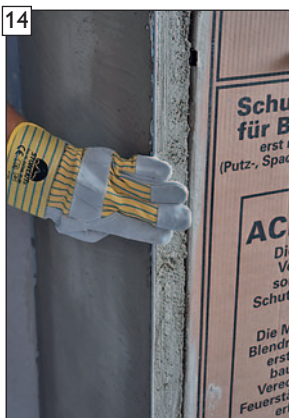
14 Eckschienenkanten noch im feuchten Zustand reinigen.
