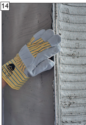
Eckschienenkanten noch im feuchten Zustand reinigen.
