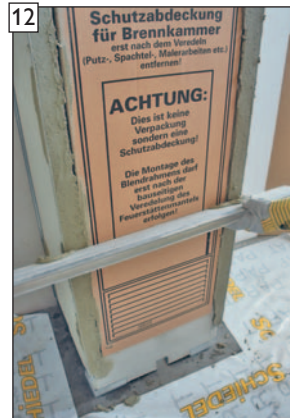
12 ... mit Kardätsche abziehen und ...
