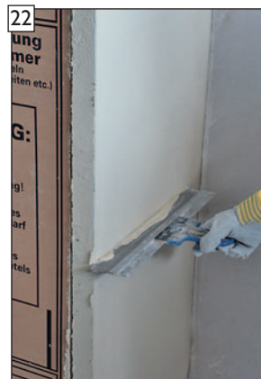
22 Oberfläche ggf. mit Flächen- spachtel nacharbeiten.
