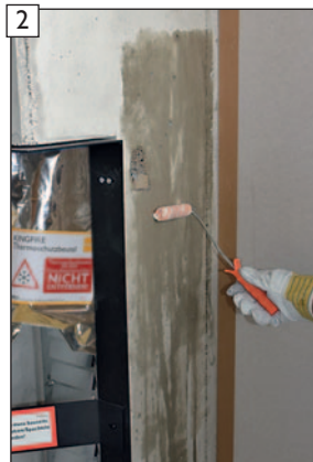
Grundierung Sopro GD 749 auf den Betonmantel aufbringen.
