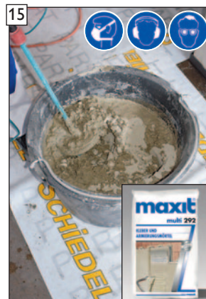
„maxit multi 292“ Oberputz gem. den Herstellervorgaben anmischen. ACHTUNG! Beachten Sie bitte die Hinweise zum Arbeitsschutz auf Seite 2!
