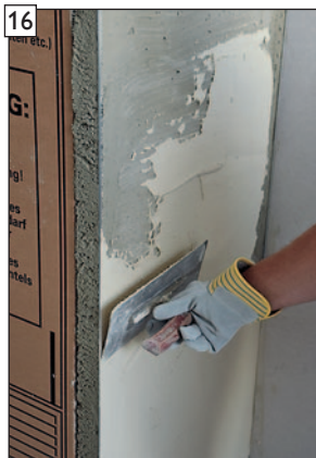
Spachtelauftrag Deck- schicht auftragen und ...
