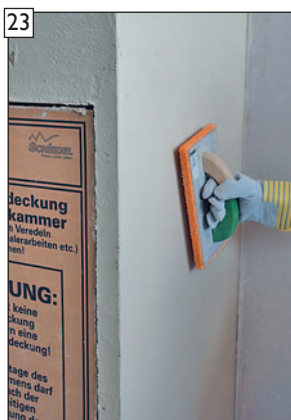
23 Oberfläche abreiben bzw. strukturieren.
