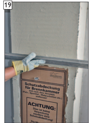
... mit Kardätsche abziehen und ...
