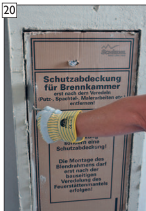
... Oberflächenspachtel an den Öffnungen abschnei- den.
