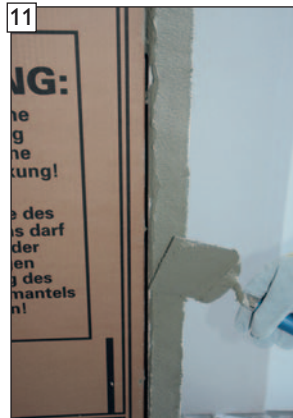
11 Haftbrückenauftrag zu den Öffnungen vornehmen, ...
