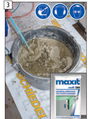
„maxit multi 280“ Haftbrücke gem. den Herstellerangaben anmischen.
