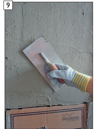
Haftbrückenauftrag vornehmen - max. Auftragsdicke 5 mm.
