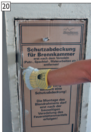
20 Oberputz an den Öffnungen abschneiden.
