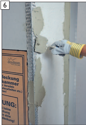
Eckprofile mit „maxit multi 280“ Haftbrücke ansetzen und ausrichten.
