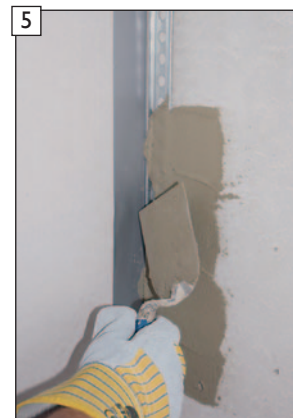
Anschlussprofile mit „maxit multi 280“ Haftbrücke ansetzen und ausrichten.
