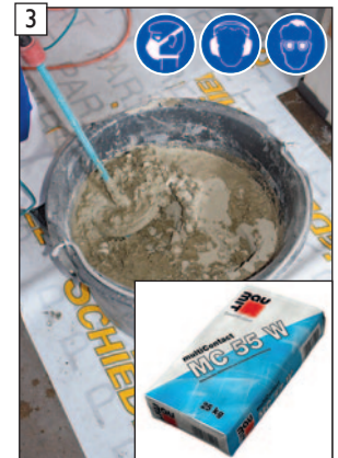
„Baumit multiContact MC 55 W“ Haftbrücke gem. den Herstellervorgaben anmischen.
