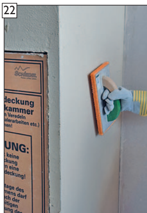
Oberfläche abreiben bzw. strukturieren.
