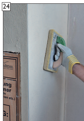
Gegebenenfalls Oberfläche im Anschluss filzen.
