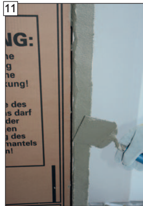
Haftbrückenauftrag zu den Öffnungen vornehmen, ...
