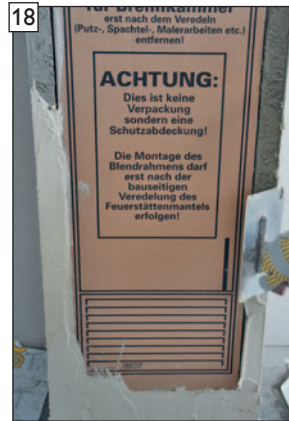
2ten Putzschichtauftrag an den Öffnungen vornehmen, ...
