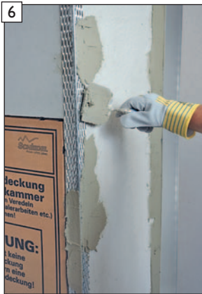
6 Eckprofile mit „maxit multi 280“ Haftbrücke ansetzen und ausrichten.
