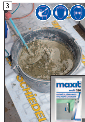
„maxit multi 280“ Haftbrücke gem. den Herstellervorgaben anmischen.
