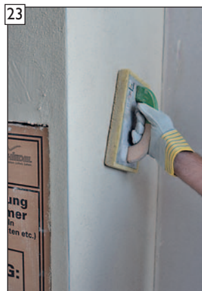
Gegebenenfalls Oberfläche im Anschluss filzen.
