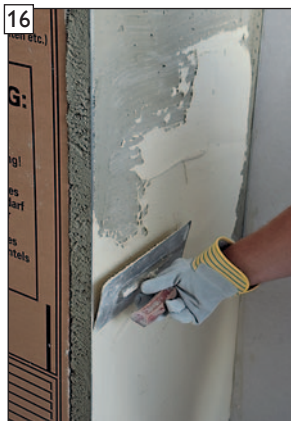
16 Oberputz auftragen und ...
