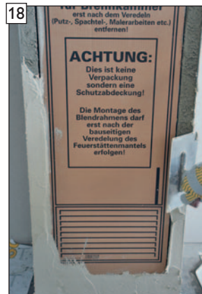
Spachtelauftrag an den Öffnungen vornehmen, ...
