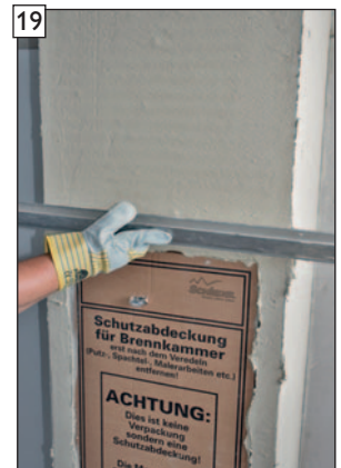
... mit Kardätsche abziehen und ...
