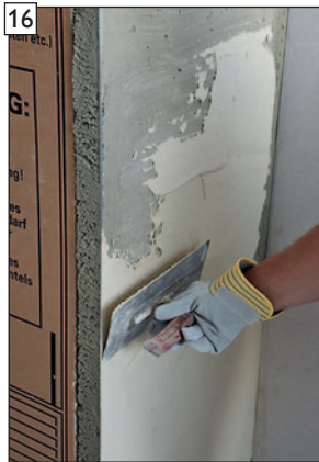
2ten Putzschichtauftrag aufbringen und ...
