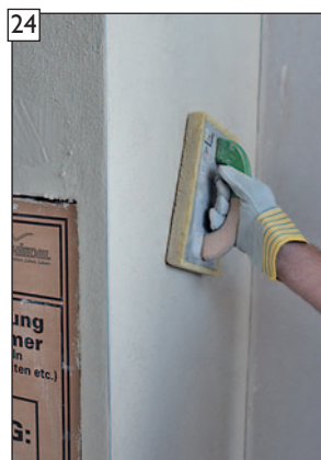
24 Gegebenenfalls Oberfläche im Anschluss filzen.
