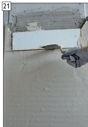
Ansicht „Abschneiden“ an der Konvektionsluftöffnung.
