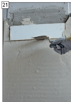
21 Ansicht „Abschneiden“ an der Konvektionsluftöffnung.
