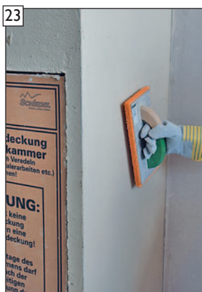
Oberfläche abreiben bzw. strukturieren.
