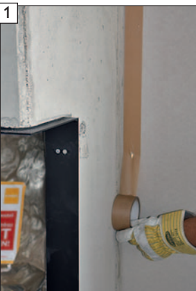
Trennband zur angrenzenden Leichtbauwand aufbringen.
