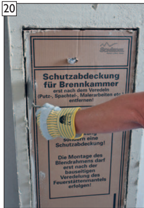
... 2ten Putzschichtauftrag an den Öffnungen abschneiden.
